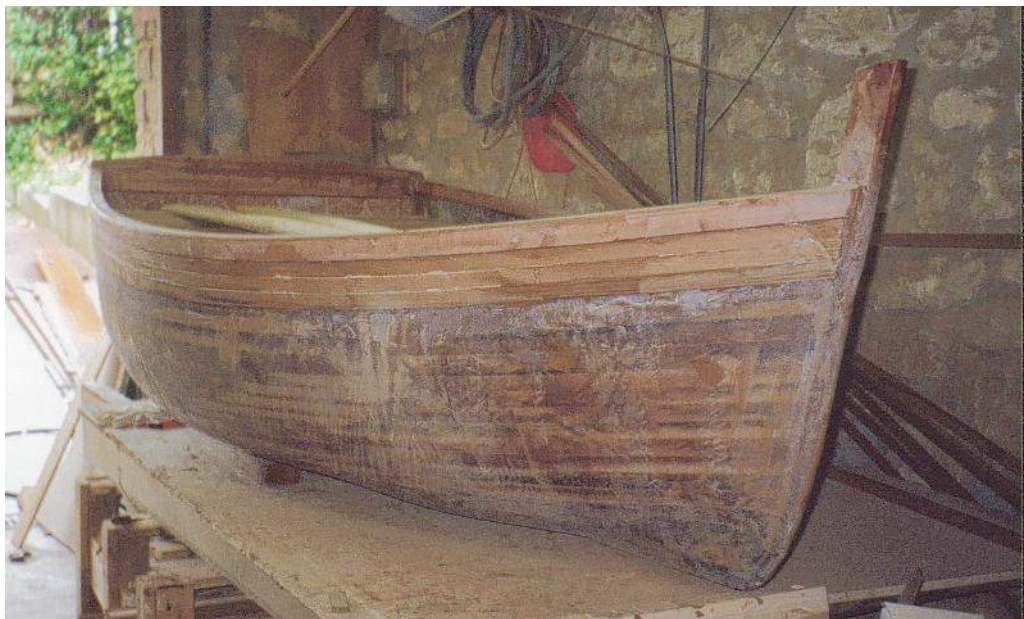
L'avantage du strip planking est qu'on peut faire des bateaux en forme.
